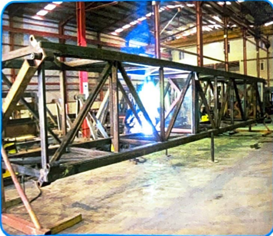
KAYNAK İSTASYONU WELDING STATION
